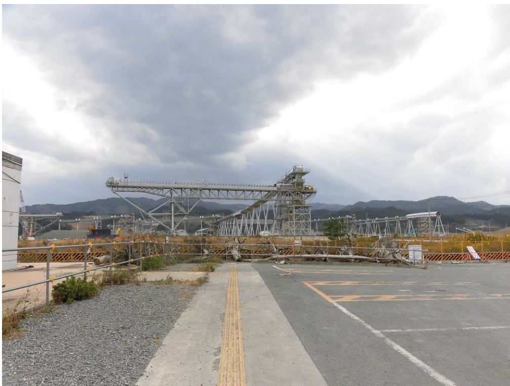
【防災集団移転の高台の掘削した土砂を運んだ巨大ベルトコンベア（解体済）（陸前高田市）】
