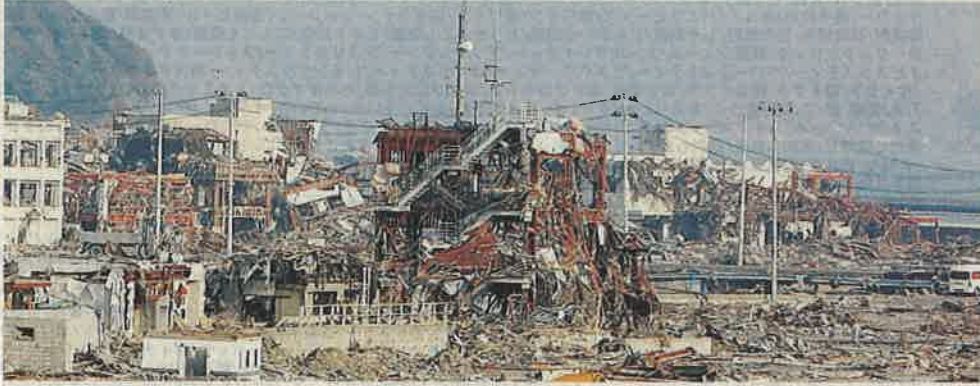
2011.4.14 震災直後の南三陸町防災対策庁舎。津波は高さ12メートルの庁舎屋上まで襲い、職員ら43人が犠牲になった
