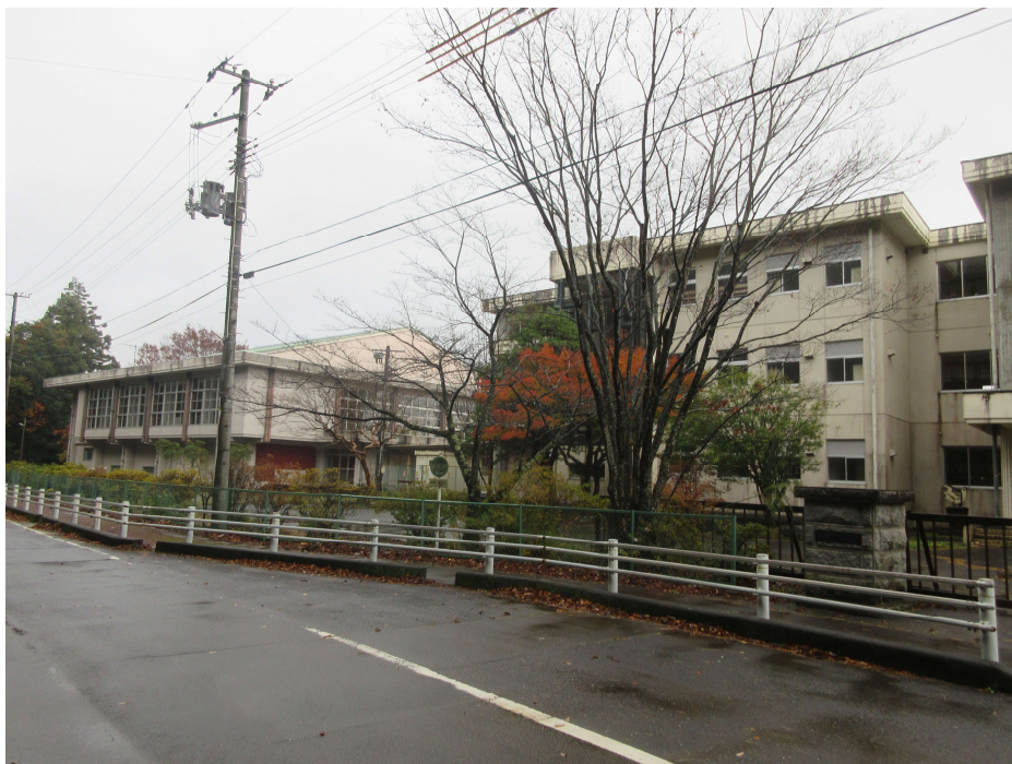
【解体工事中の荻野小学校（浪江町）】
