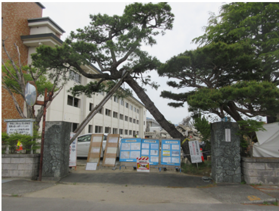
【聖火リレーの時は工事中の看板が外されたー解体工事中の浪江小学校（浪江町）】
